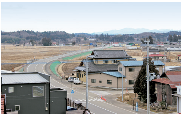
県道棚倉矢吹線バイパス川原田工区
