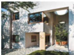
郡山地域テクノポリスものづくり インキュベーションセンター (郡山市)
