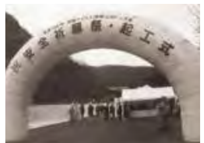
国道400号田島バイパス2号トンネル起工式。全長1,579m。
