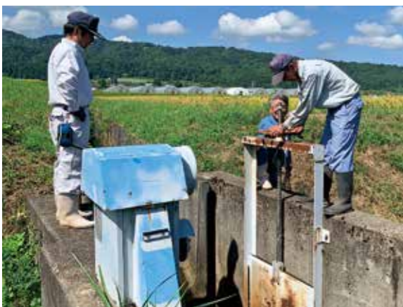
区長元のみで行う「堰上げ」分水板取り外し（雀林/9月上旬）
